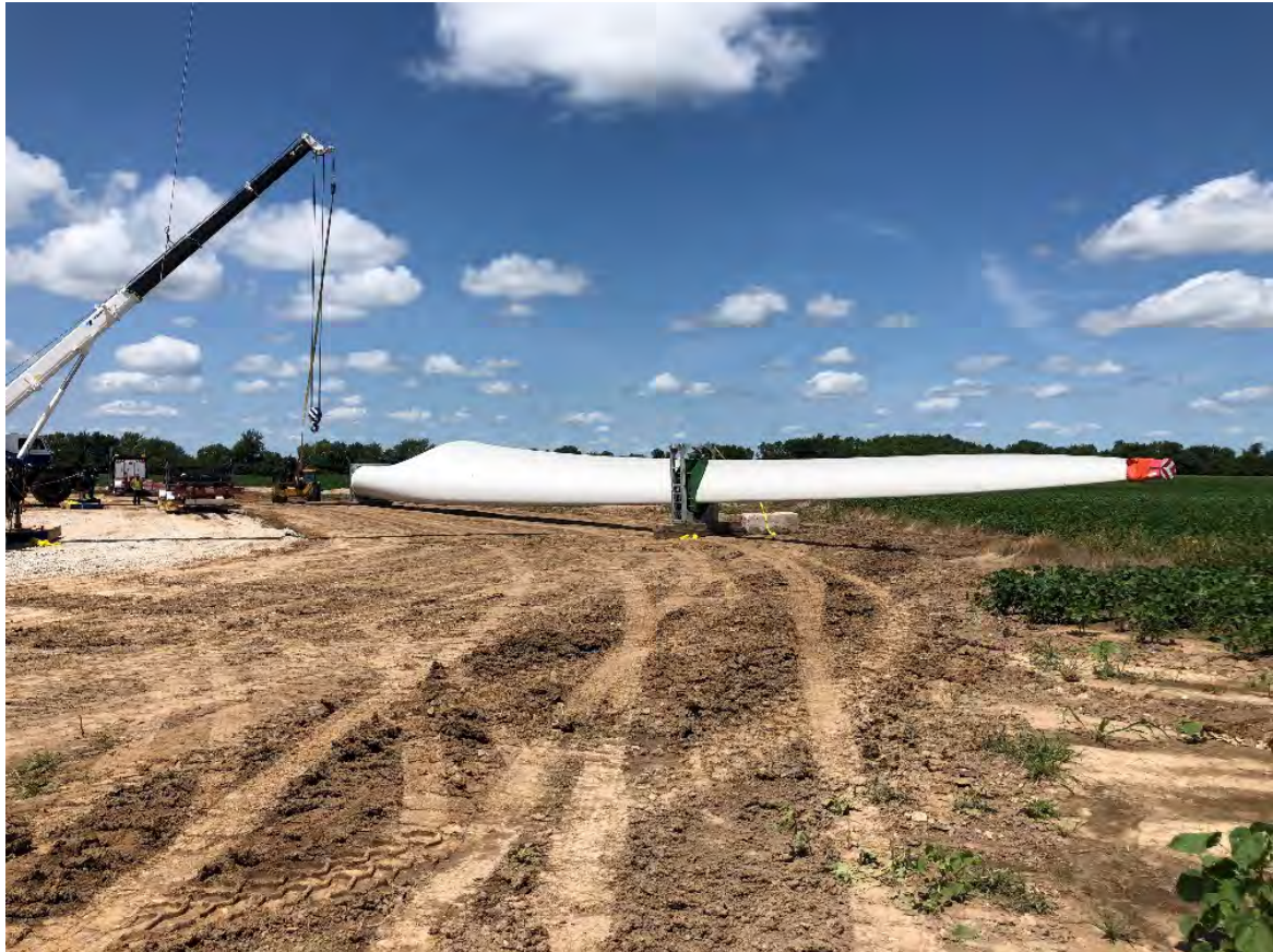
Blade Offload
