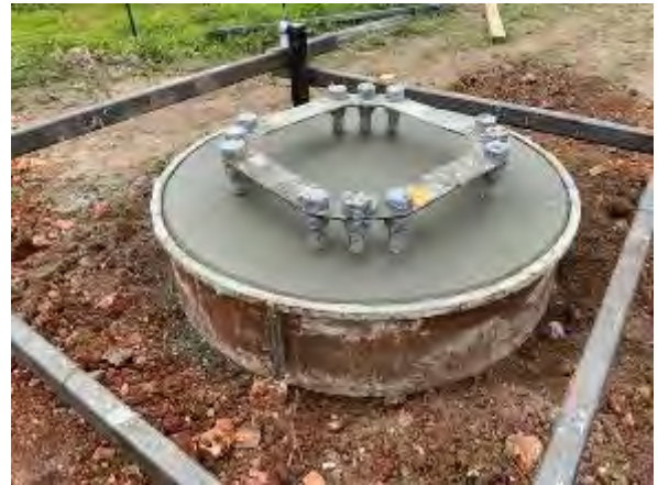
Figure 9.2: T-Line Structure 69 Pour
