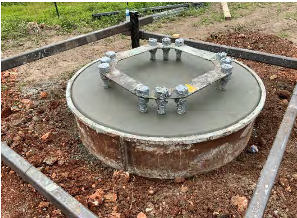
T Line Foundation Pour
