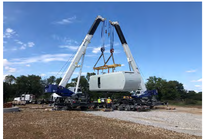
Nacelle Offload
