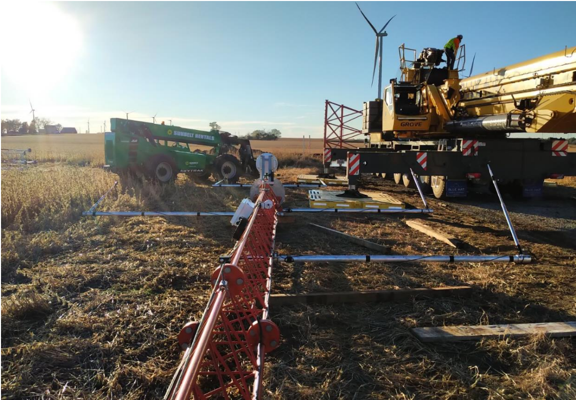
PHOTO 4: MET TOWER ASSEMBLY
