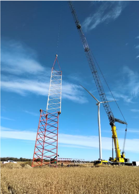
PHOTO 4: MET TOWER ERECTION
