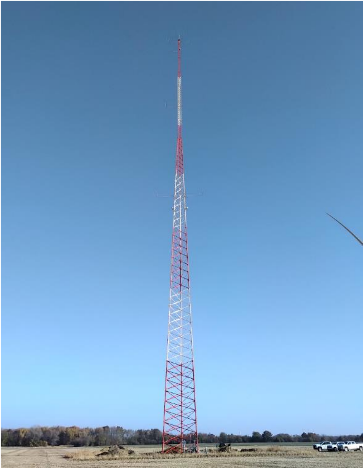
PHOTO 4: MET TOWER COMPLETE
