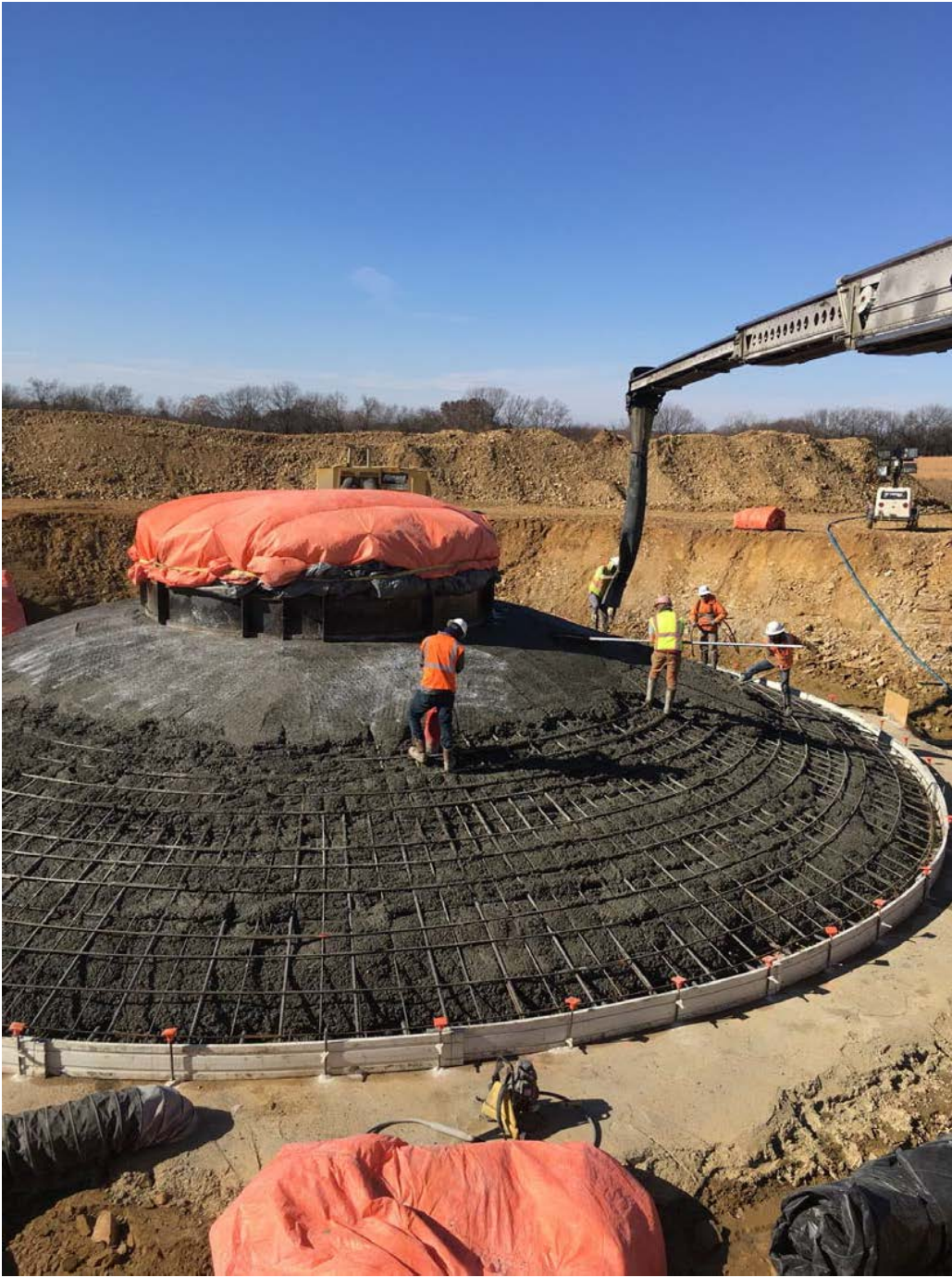
A foundation pour nears completion
