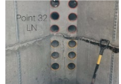
5" plastic (EB-35) conduit duct face
