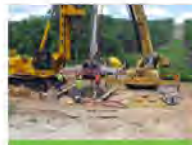
Auger holes and pour foundation
