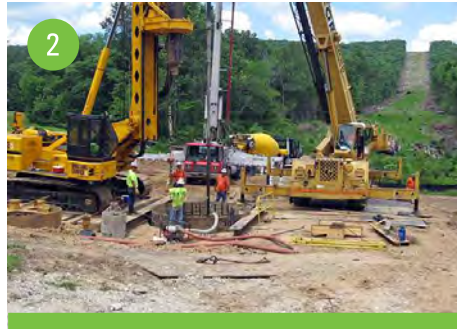
2 Auger holes and pour foundation
