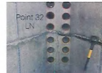
5" plastic (EB-35) conduit duct face
