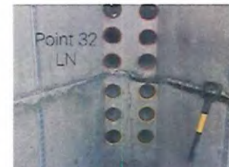
5" plastic (EB-35) conduit duct face
